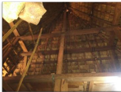
Gambar 12. Rangka ruang atap Sa'o Tua Sumber: dokumentasi peneliti
