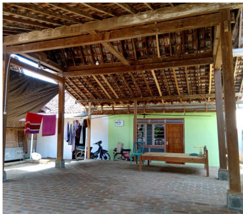
Gambar 18: Material batu bata pembentuk lantai
