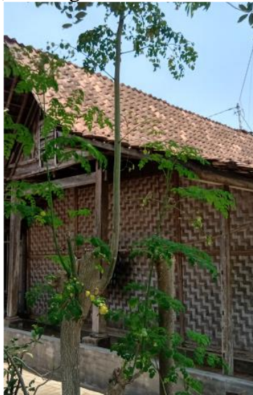
Gambar 15 : Material anyaman bambu pembentuk elemen dinding bangunan
