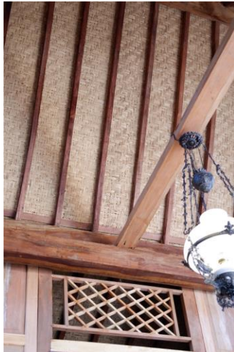
Gambar 16: Material anyaman bambu pembentuk elemen atap
