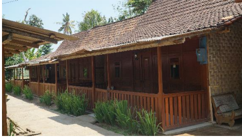
Gambar 13 : Material alami kayu pembentuk rangka dan elemen bangunan
