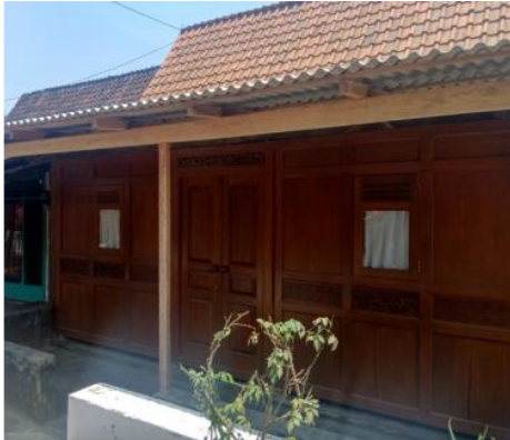
Gambar 14 : Material alami kayu pembentuk elemen dinding bangunan
