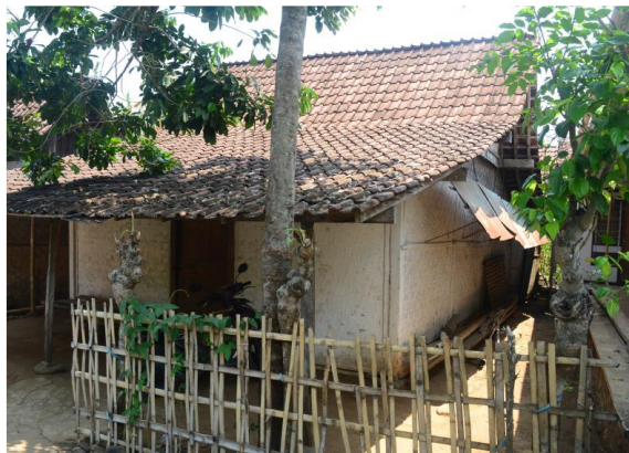
Gambar 17: Material atap genteng yang terbuat dari tanah liat
