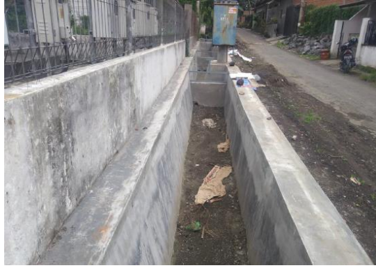
Gambar 1. Saluran drainase pada saat pembangunan
