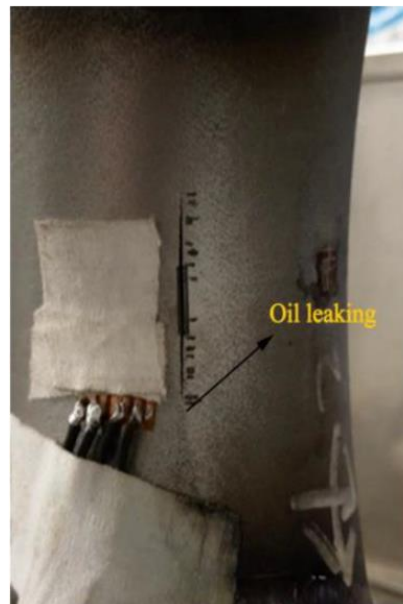
Gambar 2. Retak pada intrados pipa elbow [1].
