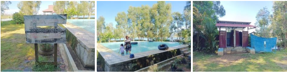
Gambar 6 Kondisi Kolam Renang Anak, Tempat Ganti Pakaian dan WC
