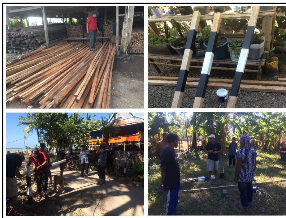
Gambar 3. Proses Pembangunan Portal Masuk Kawasan Wisata Pantai Bungung Pandang
